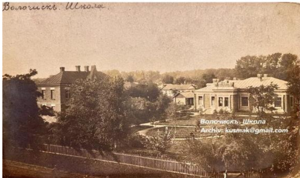
Фото 6. Будівля Волочиського однокласного залізничного училища
